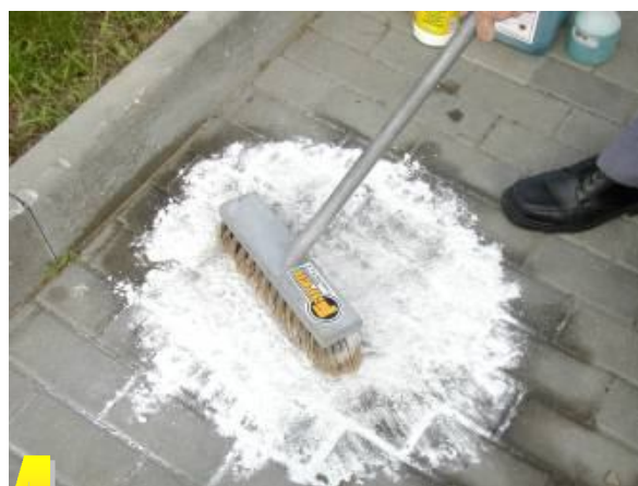
SNOW rozmést na skvrnu pomocí koštěte s tvrdými štětinami. Vyčkat 3 minuty a potom krouživými pohyby zemetat tak dlouho, dokud není skvrna zcela vstřebána.
