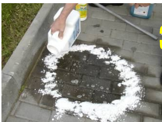
Kolem skvrny rozsypat SNOW: aby se absorboval 1l oleje z podlahy stačí 250 g.
